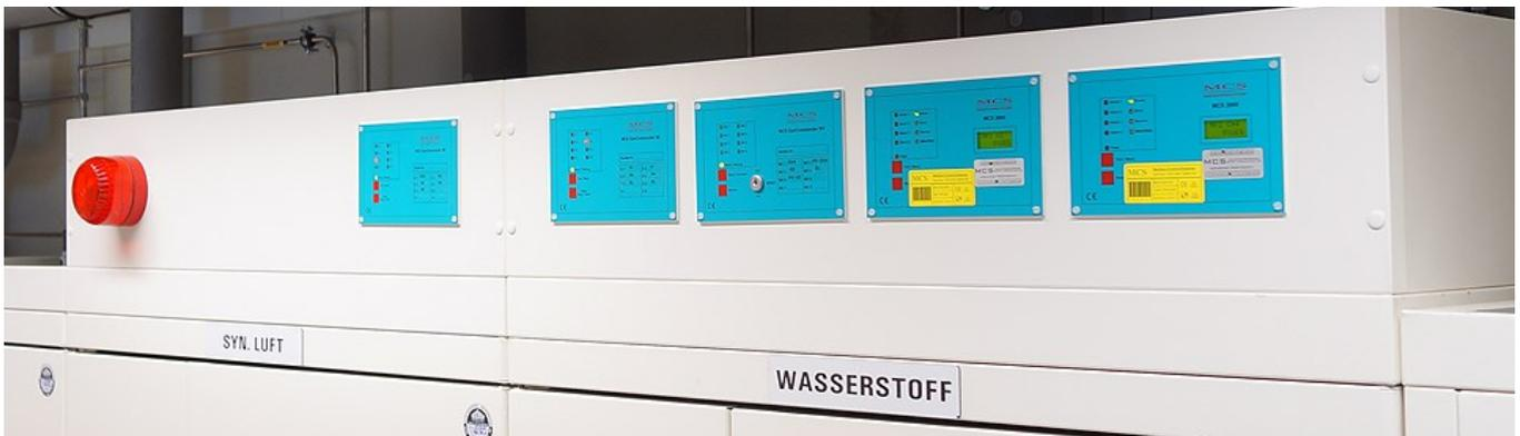
Beispiel: Gasflaschenschrank mit Gaswarnanlage, Magnetventilsteuerung mit Ventilüberwachung und Gasmangelanzeige.
